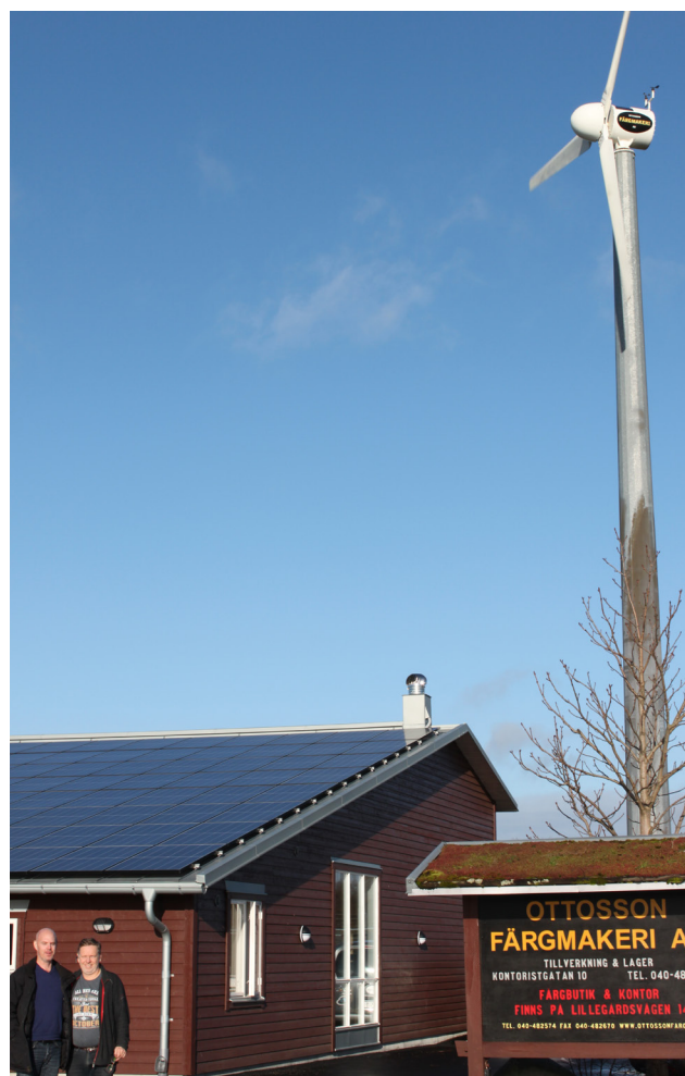
År 2007 installerades Skånes första gårdsvindkraftverk och 2017 en solcellsanläggning på taket, i samarbete med Daniel Ohlin på BBK Group.
